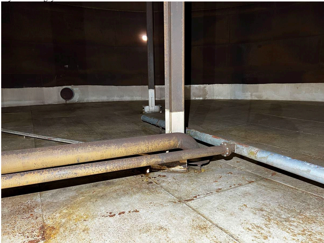
Mynd 2. Gólf og umfar geymis.
