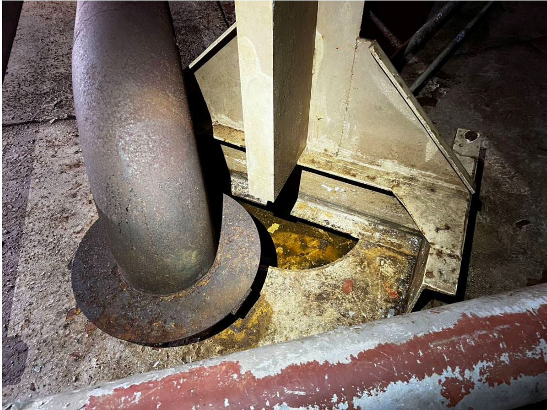
Mynd 7. Svelgur. Mjög erfitt aðgengi og málning illa farin.
